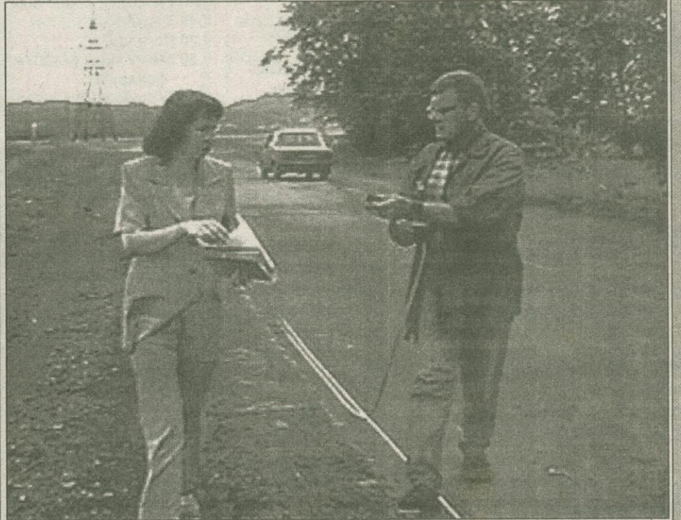
Комиссия принимает дорожный участок после завершения ямочного ремонта. Фото С. ЗЫРЯНОВА
