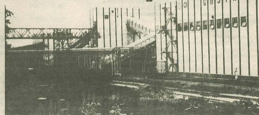
обогащается уголь. Существует три модуля обогащения: уголь размером 13-150 мм, 2-13 и 0-1 мм. Крупный уголь, к примеру, загружается в тяжелосредный сепаратор, где смешивается с суспензией. В результате смешивания порода тонет, а уголь всплывает и поступает на специальный двухситный конвейер для обезвоживания. Самый мелкий уголь подается в гидроциклонные классификаторы, которые вращаются с определенной скоростью. За счет гравита-
