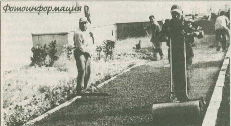
Полысаево готовится к встрече поистине всенародного праздника — Дня шахтера, с каждым днем становясь благоустроеннее, краше и чище. На снимке: идет прокладка нового тротуара на улице Космонавтов у дома №90. Фото В. КИРИЛЛОВА.
