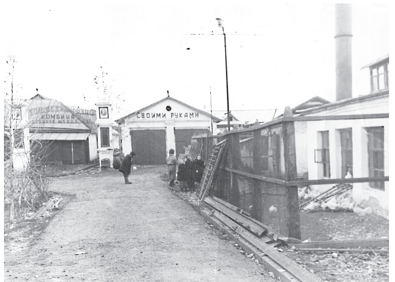
Политехнический комбинат школы №17.
