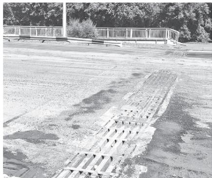
И вот уже дорожники заканчивают фрезерование полотна и начинают укладку выравнивающего слоя. Кроме того, они заменяют на мосту удерживающие конструкции. Работают в основном по ночам, чтобы минимизировать
