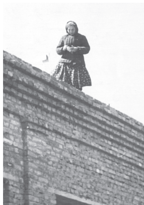
П.Г. Куца на строительстве своего первого объекта - АБК шахты «Полысаевская-3» («Кузнецкая») в 1956 г.
